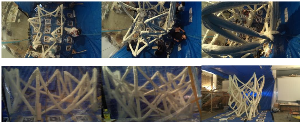
図 10. 建設工程. 左から 1 層目, 2 層目, 3 層目. 上の段は現場の上から, 下の段は現場の横からの撮影.
